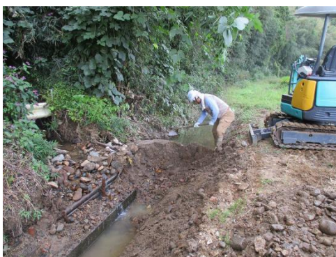
大里(川原) 農道整備・ 排水路整備
