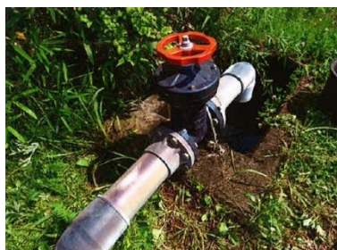
[高瀬 ゲートバルブ 取替工事]
