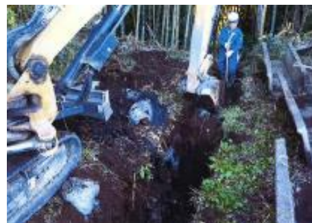
[大里 排水路修繕工事]
