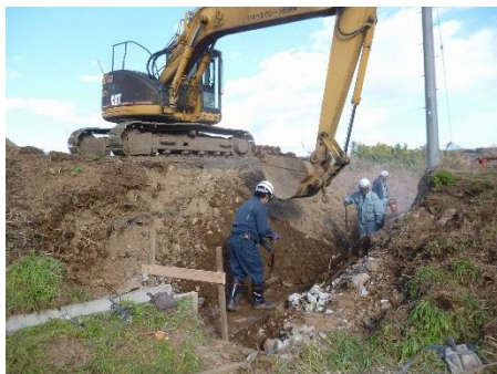
[大里 河原 横断道路水漏れ修繕工事]
