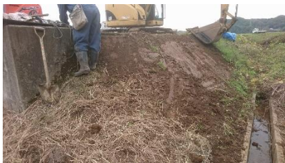
[小埜 用水路水漏れ修繕工事]
