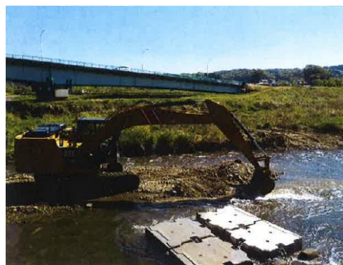
[大里 根固めブロック設置工事]
