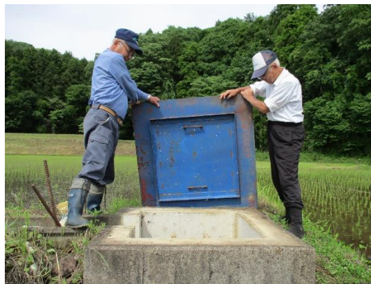
<森田/農業施設の点検確認>
