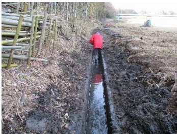
<仕上げは手作業>
