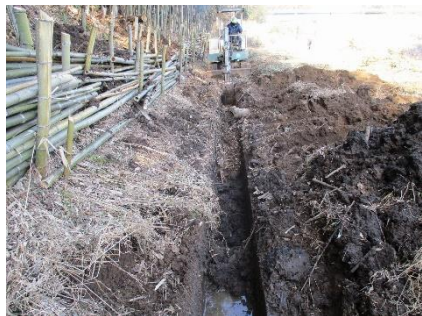
<重機による土砂浚い>
