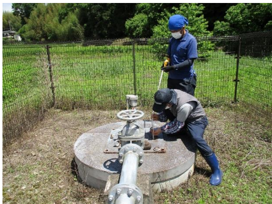
<小埜/9号揚水機場の砂等の堆積量確認>
