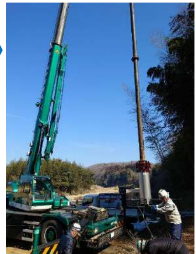
＜25tクレーンによるポンプ交換工事＞
