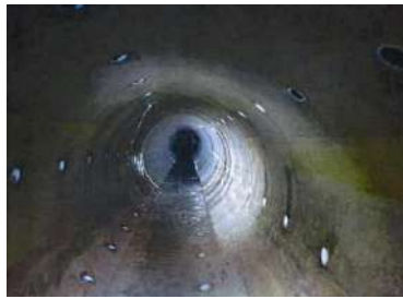
＜清掃後の既設ヒューム管内＞
