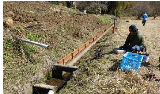
<小埜 水路の補修>
