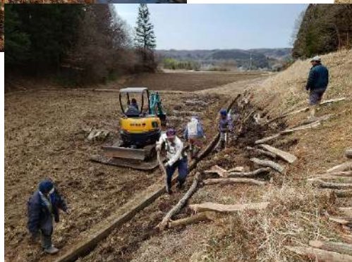
＜高瀬 ため池堤体補修＞
