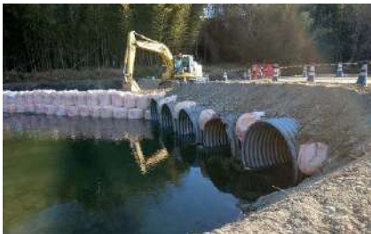
＜工事用道路・仮締切の工事＞
