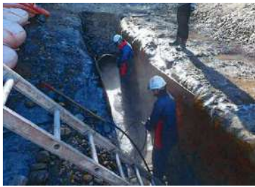
＜ジェット噴水による泥砂清掃＞
