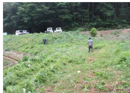
＜高瀬 ため池堤体草刈り＞
