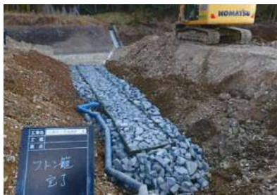
＜カゴマット設置＞
