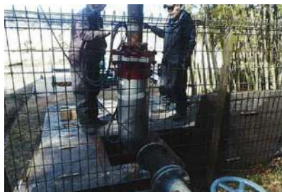
＜25tクレーンによるポンプ交換工事＞
